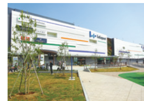
電気設備工事
